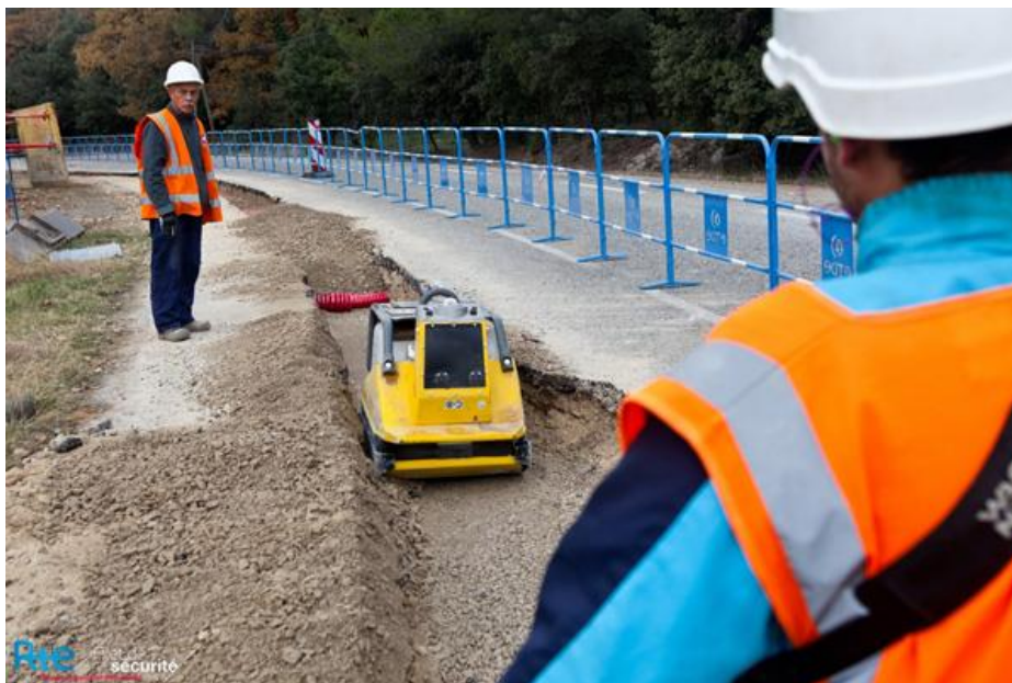
Mynd RTE: Frágangur á 225kV streng RTE í Frakklandi
